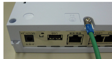
図① アース線取付状態
